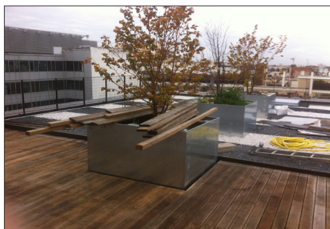
Niveau R+9 : Platelage bois
