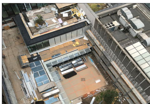
Vue niveau rez-de-chaussée et R+1 : voirie en enrobé, jardinières, cornières et bardage métalliques
