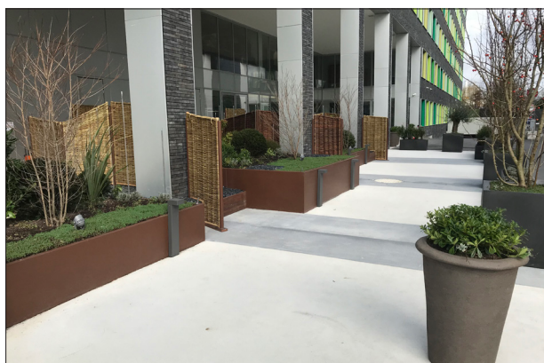
Vue d'ensemble : Revêtements de sols en dalles de grès Cérame et béton de résine, mobilier et éléments décoratifs
