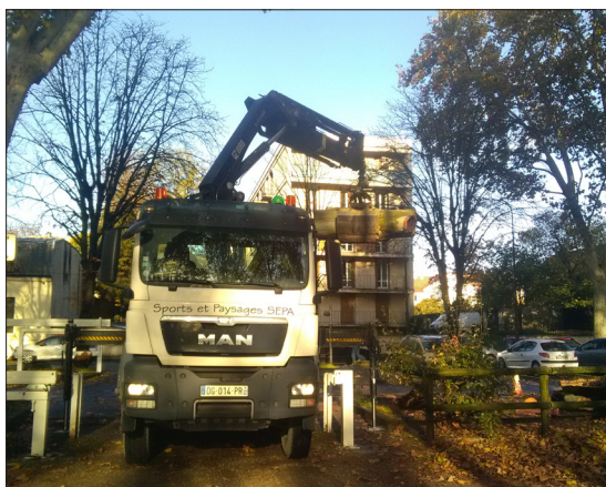
Chargement des troncs au camion-grue
